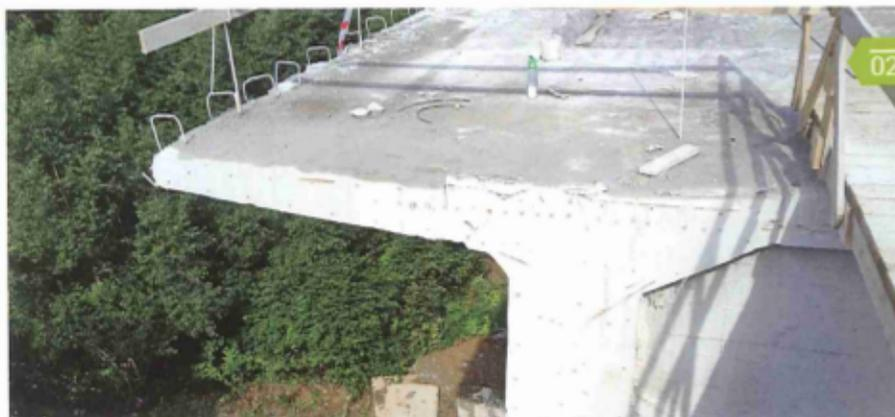
16 Teile à 4t. Die Sägearbeiten wurden mittels Seilsäge und teilweise mit der 32kW starken Wandsäge von EDT Eurodima durchgeführt. Auch hier kamen sowohl das Premium-Diamantseil DS40FBLUE und die schnittigen EURIX-Wandsägeblätter von EDT Eurodima zum Einsatz. Die Arbeiten erstreckten sich über einen Zeitraum von etwa zwei Monaten.
